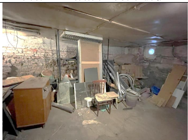
Фото 32. Типичное состояние Объекта оценки
