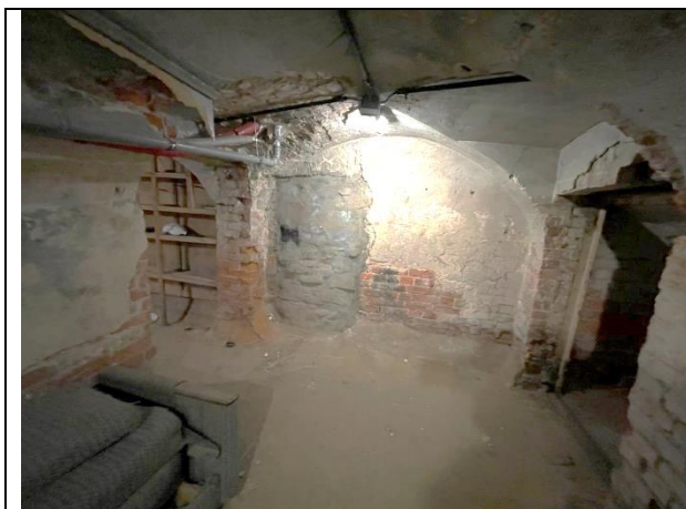
Фото 29. Типичное состояние Объекта оценки
