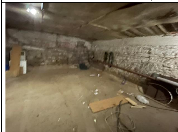
Фото 31. Типичное состояние Объекта оценки
