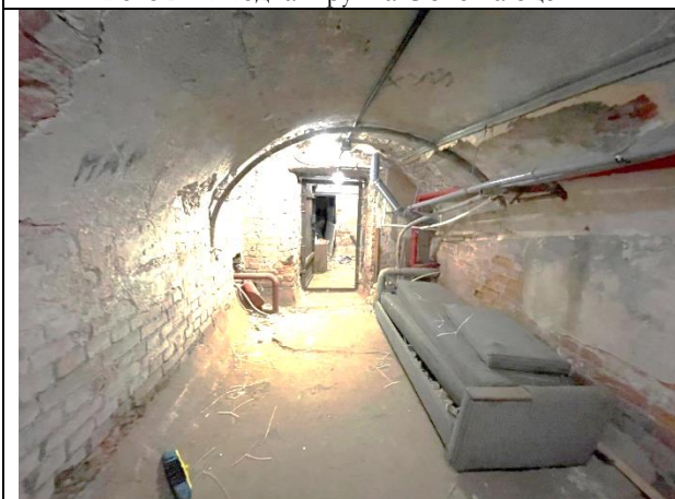
Фото 23. Типичное состояние Объекта оценки
