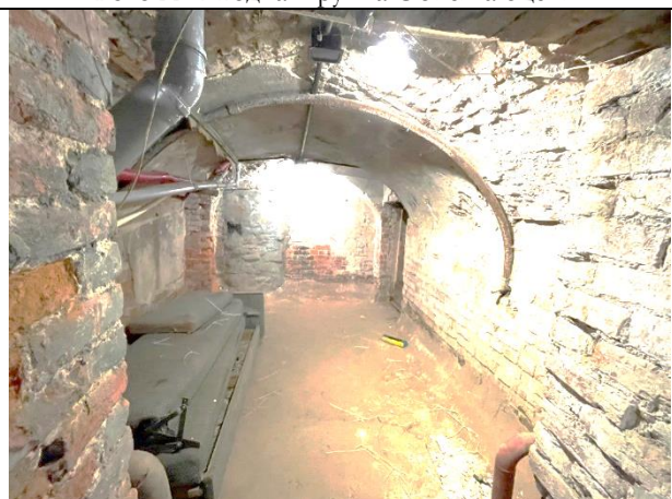
Фото 24. Типичное состояние Объекта оценки
